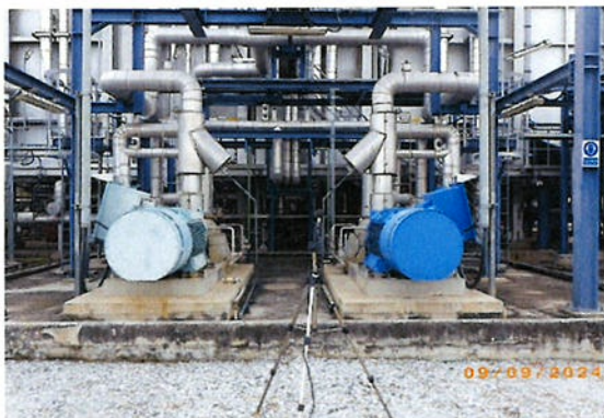
Boiler Feed Pump HRSG#12
